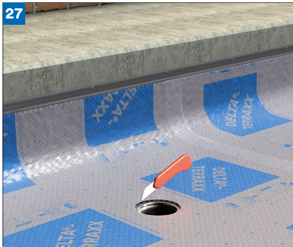
(obr. 27 a 28) Otvory pre strešné vpuste opatrne vyrezať odlamovacím nožom. Hydroizolácia sa pritom nesmie poškodiť. Následne zamontovať strešnú vpusť.
